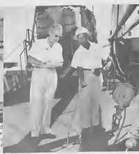
SAVBOLT'S OIL Inspector, J. T. Dooley, witnesses Lago Gauger E. Pilgrim perform ullages on the Mormacwren. SAVBOLT' SU inspector di azeta, J. T. Dooley ta waak gauger di Lago E. Pilgrim ta midí cuantia tin den tanki di SS Mormacwren.
